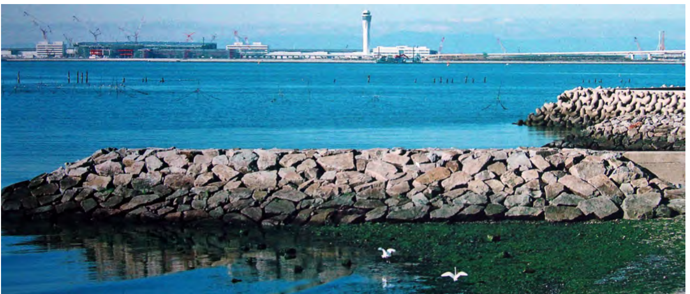
管制塔など空港諸施設の建設が進む 2003.11 樽水旧西北小護岸堤より
