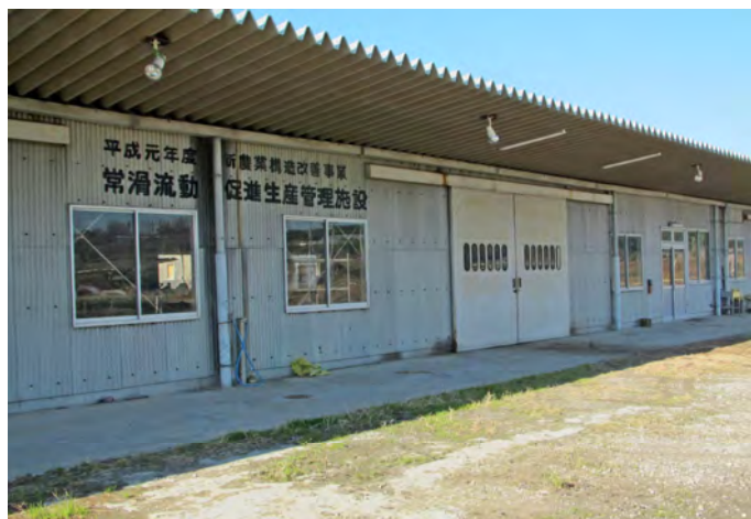
生産の拠点 JA農機具格納施設
