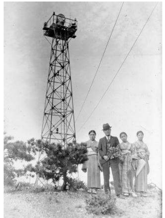
光源1KWの大型航空灯台
