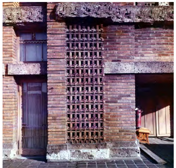
スダレ煉瓦と大谷石の外装
