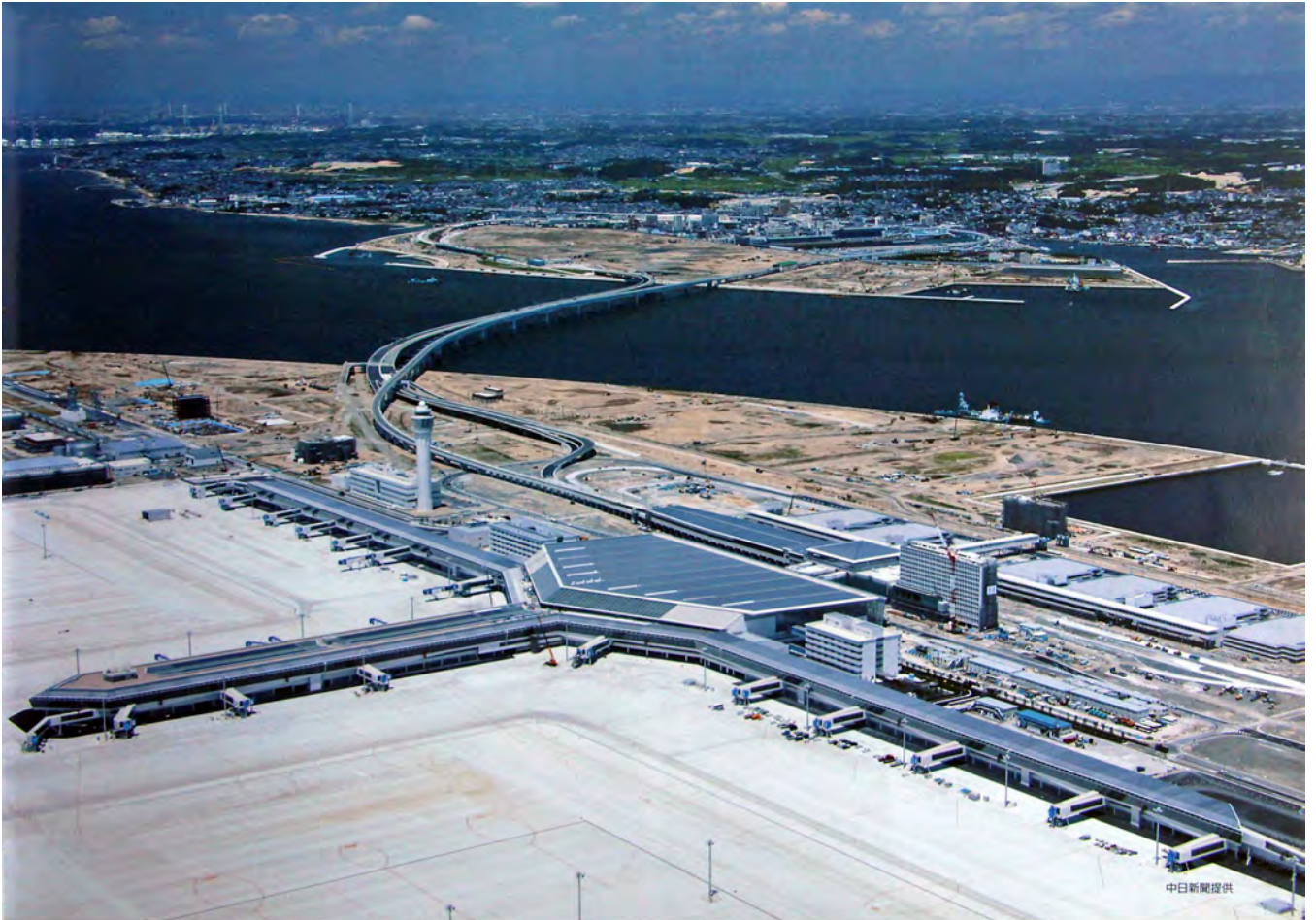
完成した「中部国際空港」 対岸は前島埋立地 （中日新聞提供）
