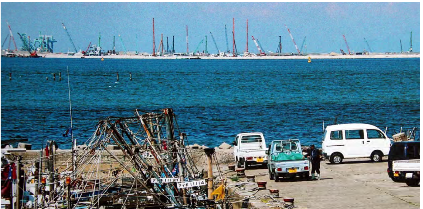
旅客ターミナルビルの建設工事の様子 2002.3 樽水漁港より
