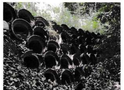
土管で修復した津島神社裏山法面
